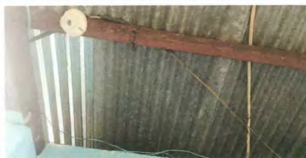
Foto 6.1: Sustitución de Plafoneras y cable paralelo.
