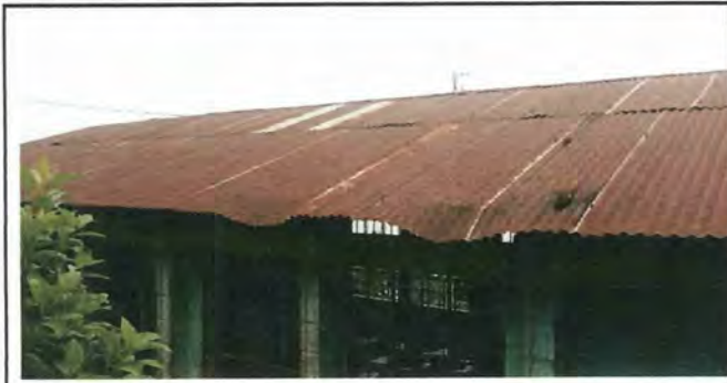
Foto1: Sustrucción de laminas acanadas en mal estado por laminas troqueladas.
