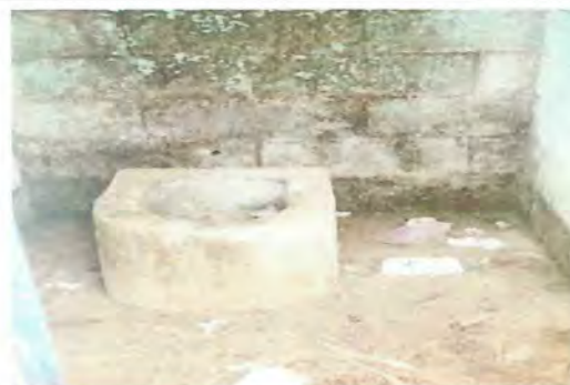
Foto 5.1: Mantenimiento de Tasas de Sanitario.
