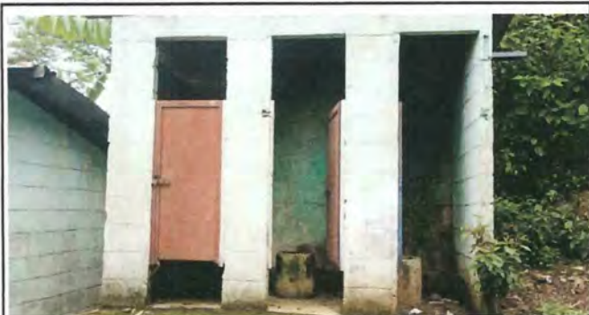
Foto5: Mejoramiento de servicios sanitarios.
