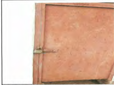
Foto 2: Mantenimiento a puerta de metal ( Lijado y pintado)
