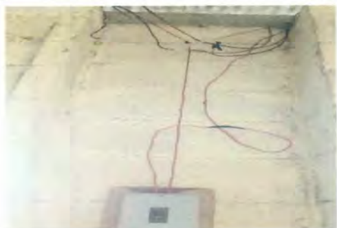
Foto 6: Reparación de Sistema Eléctrico.
